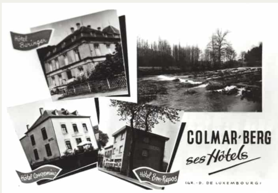
◀ Hotels in Colmar-Berg, die ab der Mitte des 19. bis zur Mitte des 20. Jahrhunderts entstanden sind
