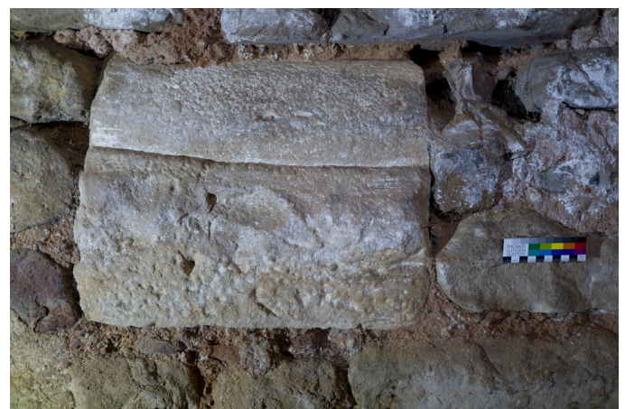
▲ Abb. 20 Nordostwand der Scheune mit dem zweitverwendet verbauten birnenstabförmigen gotischen Rippenstein (Aufnahme, Dr. phil. Dr.-Ing. Thomas Lutgen, November 2023).
