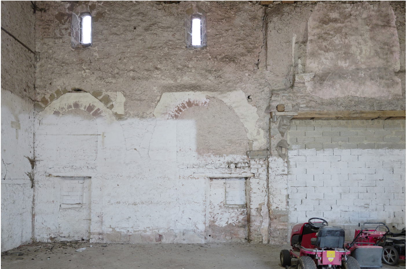
▲ Abb. 3 Nordwand der Scheune mit den Resten von zwei mittelalterlichen Mittelschiffarkadenbögen (Aufnahme, Dr. phil. Dr.-Ing. Thomas Lutgen, November 2023).
