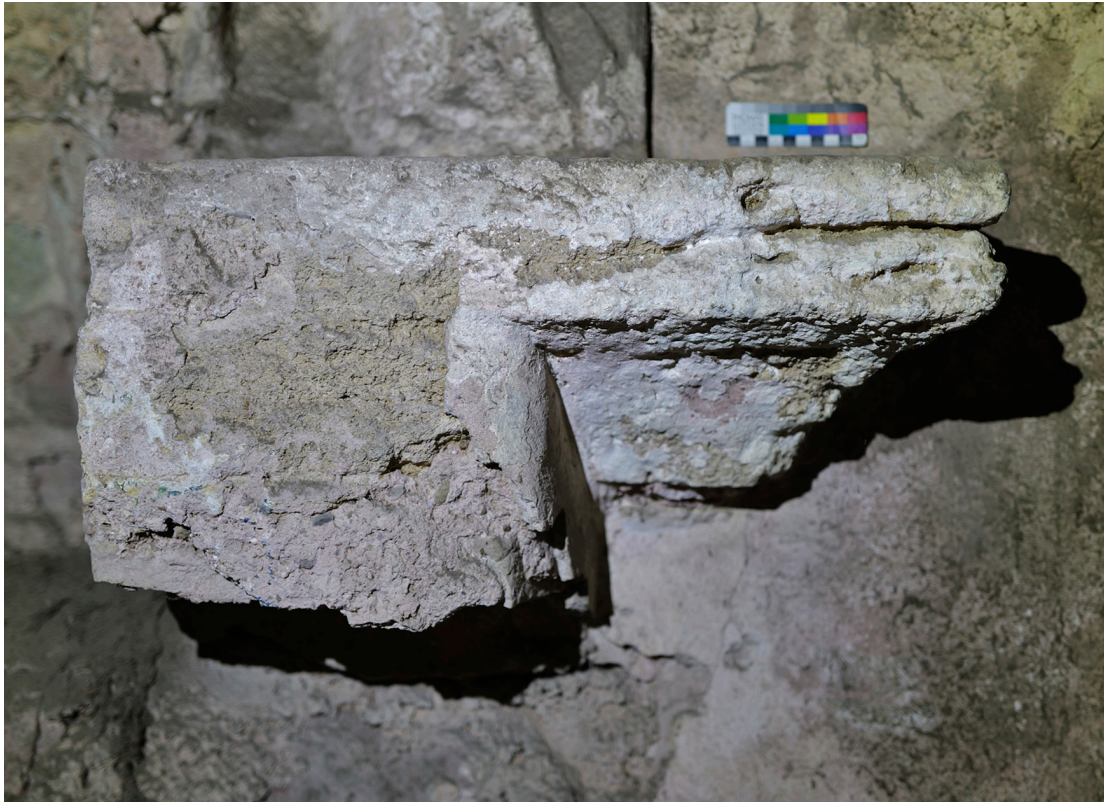
◀ Abb. 18 Nordwestwand der Scheune im Bereich des gotischen Querhauses mit der Wandkonsole für die Kreuzrippeneinwölbung (Aufnahme, Dr. phil. Dr.-Ing. Thomas Lutgen, November 2023).
