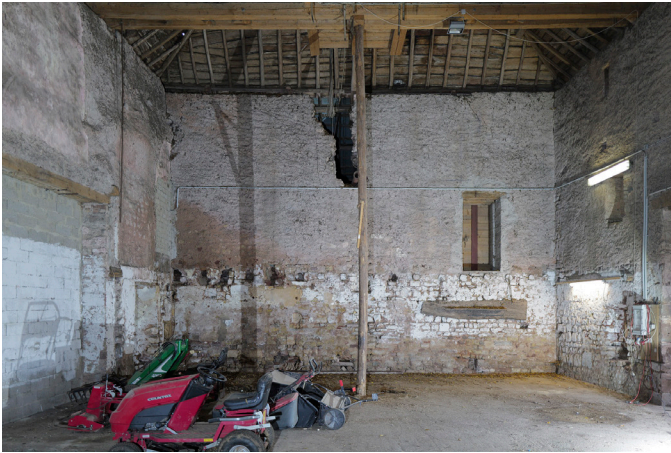
▲ Abb. 5 Nordostwand der Scheune mit der im Barock aufgemauerten Bruchsteinwand (Aufnahme, Dr. phil. Dr.-Ing. Thomas Lutgen, November 2023).
