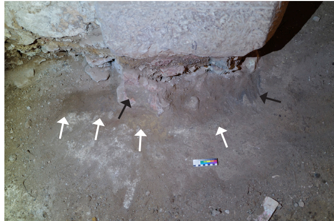
▲ Abb. 7 Durchbrochene Estriche südöstlich des Pfeilersockels im mittleren Raum der südöstlichen Zone (weiße Pfeile), Ascheschicht (schwarzer Pfeil rechts), wiederverwendeter Bruchstein mit Brandschäden (schwarzer Pfeil links) (Aufnahme, Dr. M. Lüpnitz, November 2023).
