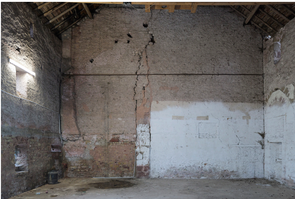
▲ Abb. 3 Nordwand der Scheune mit den Resten von zwei mittelalterlichen Mittelschiffarkadenbögen (Aufnahme, Dr. phil. Dr.-Ing. Thomas Lutgen, November 2023).
