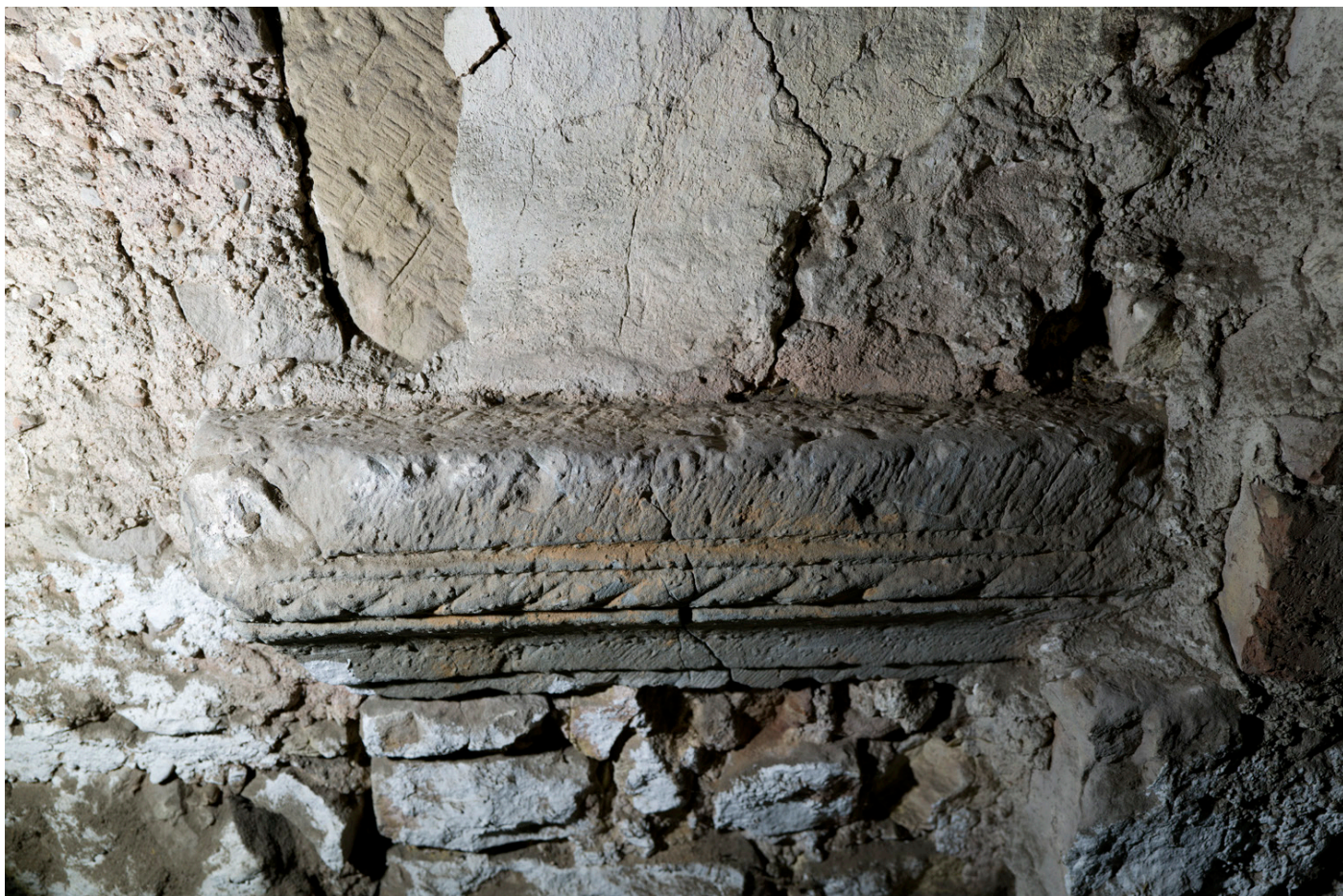
▲ Abb. 14 Nordwestwand der Scheune mit einer stark verwitterten Kämpferplatte mit gedrehtem Tau eines romanischen Mittelschiffarkadenbogens (Aufnahme, Dr. phil. Dr.-Ing. Thomas Lutgen, November 2023).
