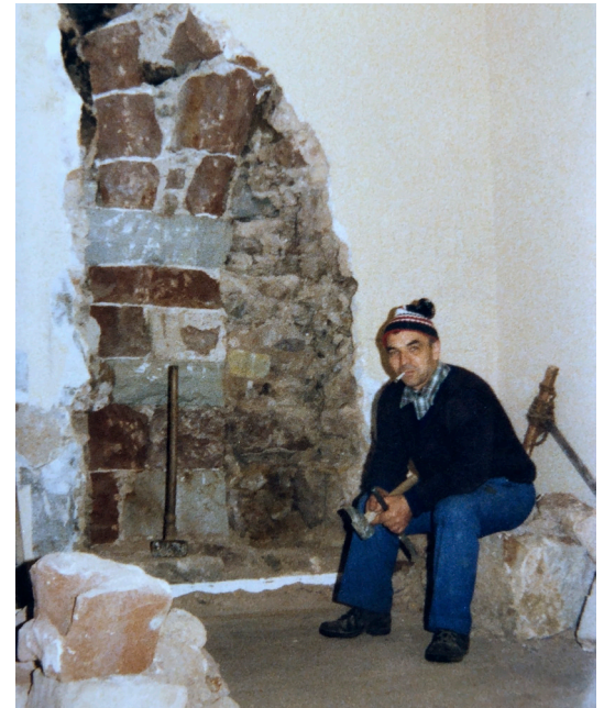
▲ Abb. 9 Maueröffnung für den Einbau eines offenen Kamins im Wohnhaus im ersten Geschoss mit einem freigelegten romanischen Arkadenpfeiler (Quelle: Aufnahme Familie Vaudrey, von Herrn Georges Majerus zur Verfügung gestellt).
