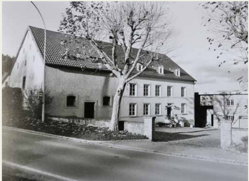
► Blick auf das wohl um die Mitte des 18. Jahrhunderts entstandene Wohnhaus des Klingelscheuerhofs, 2008 Azzeri, Roland, Klingelscheuer. Ferme (...) , [Fotografische Aufnahme], Commission des Archives Lorentzweiler, Klingelscheuer, 2008.
