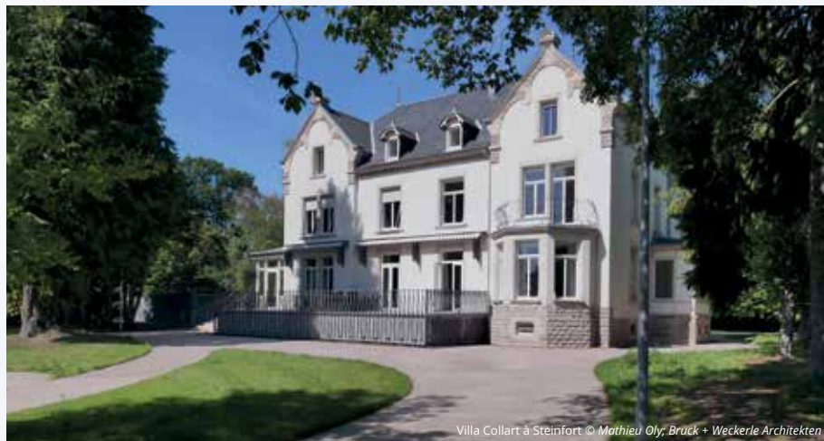
Villa Collart à Steinfort © Mathieu Oly, Brück + Weckerle Architekten
