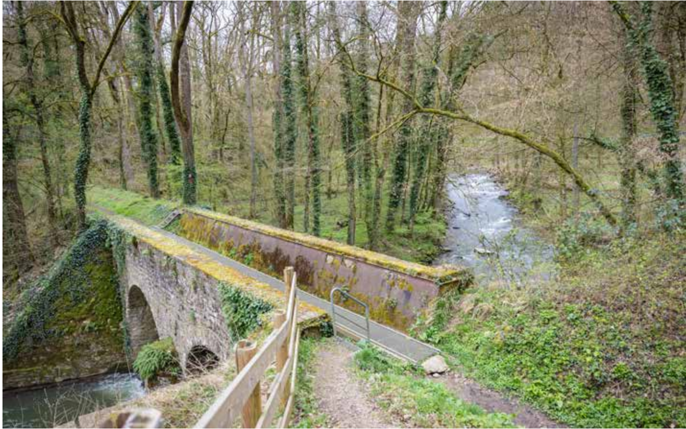
Le pont en pierre naturelle, seul aqueduc de ce type existant au Luxembourg, enjambe la Syre avec ses deux passages voûtés. À la sortie de l'aqueduc, l'eau passait sous la route et coulait vers l'ancienne scierie. Le dénivelé de 27 mètres entre la scierie et la Syre alimentait jadis les turbines. Le développement des nombreux moulins de la vallée de la Syre a débuté au milieu du XVIIe siècle, lorsque le seigneur de Berbourg établit une fonderie au bord de la rivière. Comme la technologie devenait obsolète - avec des laminoirs qui remplaçaient les méthodes de forgeage - le fabricant de papier et de tapisserie Eugène Lamort transforma l'ancienne fonderie de Manternach en papeterie, cela vers 1875. Il construisit à proximité un moulin pour traiter les chiffons utilisés dans la fabrication du papier et ajouta une scierie.
