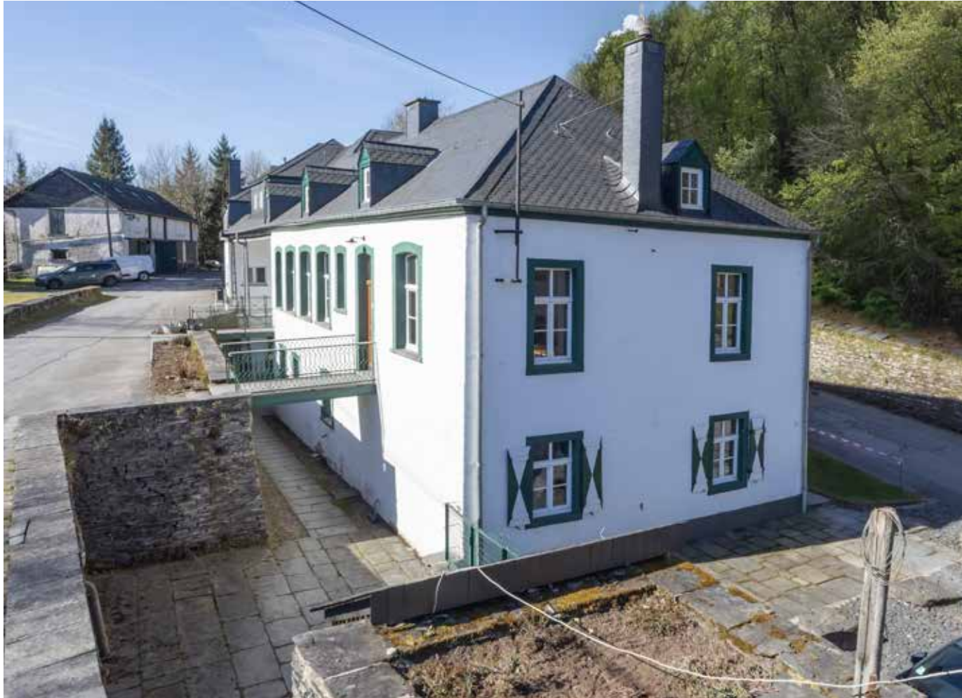
L'ancien bâtiment administratif fut érigé à la fin du XIXe siècle et servait la famille Nanquette, l'une des premières familles d'industriels à Haut-Martelange, comme maison d'habitation. Avec l'arrivée des frères Rother et le développement économique des ardoisières au début XXe siècle, le bâtiment est devenu le siège administratif du site et a été agrandi à plusieurs reprises. On y trouvait le secrétariat, la comptabilité, les bureaux du directeur. Au rez-de-chaussée furent installées des chambres pour les hôtes du patron.
