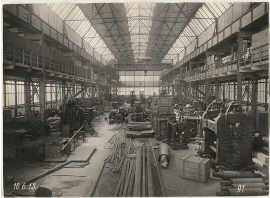
L'atelier central, représenté ici après son achèvement en 1913, regroupait l'atelier des machines-outils, l'atelier des machines à cylindres ainsi que l'atelier d'apprentissage, la « Léierbud ». En 1937, le bâtiment a été agrandi par l'ajout de deux nefs latérales afin d'accueillir l'atelier de construction.
