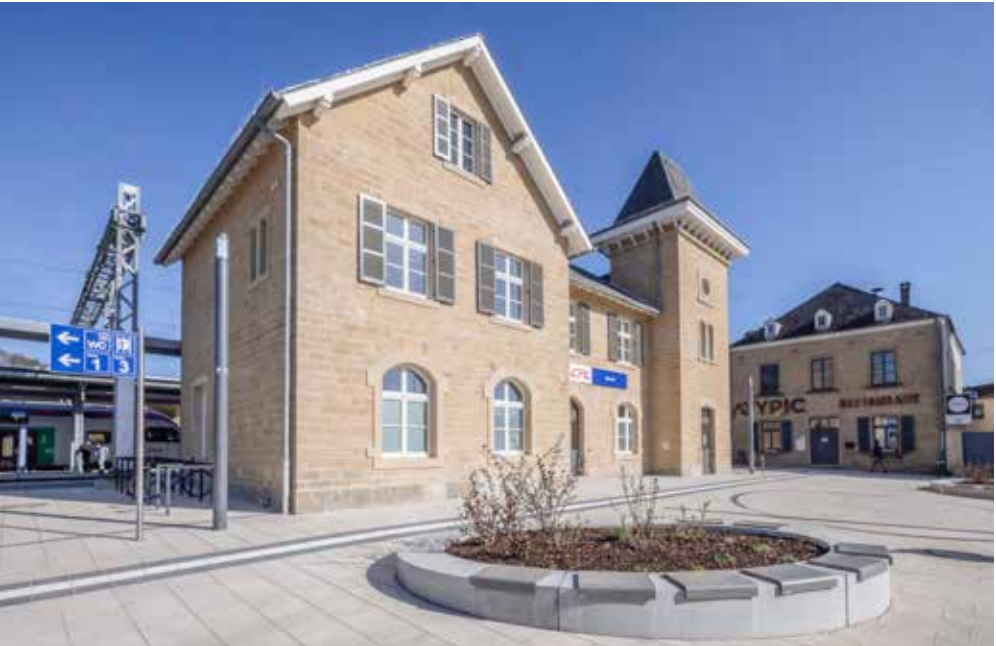
Le bâtiment de la gare historiciste de Mersch a été construit vers 1862 par la Compagnie Guillaume-Luxembourg, lors de l'achèvement de la ligne ferroviaire nord-sud reliant Luxembourg, Mersch et Ettelbruck. À la lisière nord-est de Mersch, il forme un ensemble avec l'ancien Hôtel de la Gare adjacent au sud, un petit clocher et le poste d'aiguillage.
