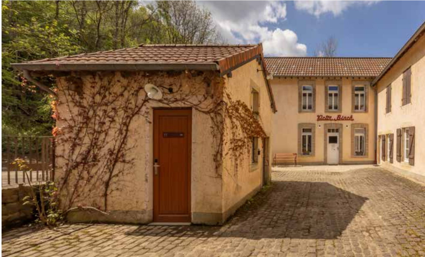
Les anciennes habitations ouvrières appartenaient à la société minière Providence et servaient de dortoir aux mineurs.
