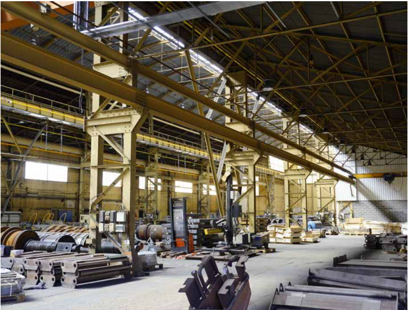
Avec sa façade en charpente métallique remplie de briques de laitier et sa structure porteuse en acier avec pont roulant intégré, l'ancienne forge construite au milieu du XXe siècle constitue un exemple typique et bien conservé des halles industrielles de cette époque.
