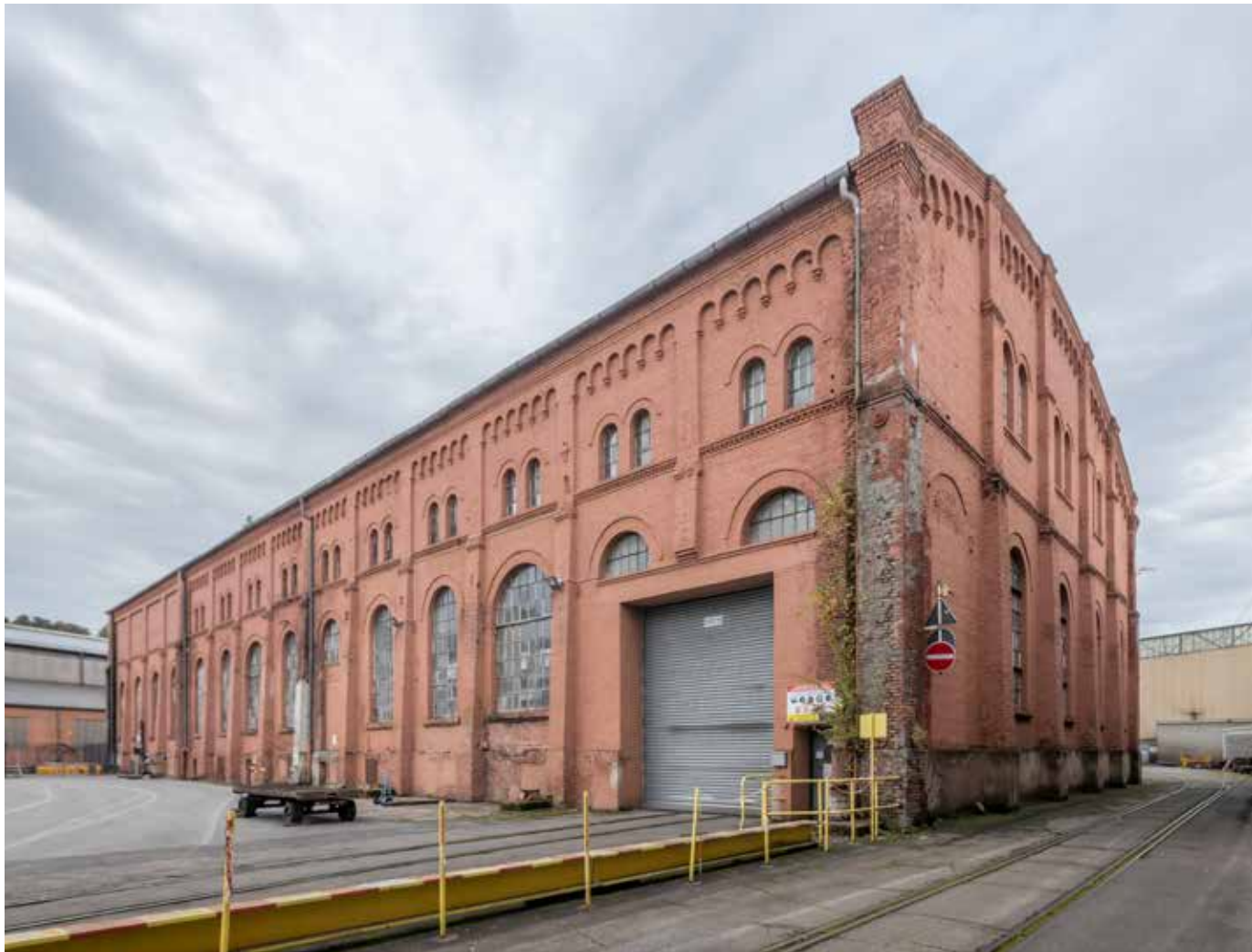
La nouvelle centrale électrique a été construite vers 1910. Au moment de l'installation de nouveaux moteurs, probablement vers 1940, la halle a été prolongée et des parois extérieures ont été démolies pour permettre l'installation de nouveaux moteurs. La façade principale se divise en deux parties, dû à l'extension du bâtiment de 1910 vers l'ouest. La structure historique est divisée en dix sections, séparées par des pilastres verticaux finement travaillés et maçonnés. La centrale électrique fournissait l'électricité pour le site ainsi que pour la Ville de Luxembourg et son tramway.
