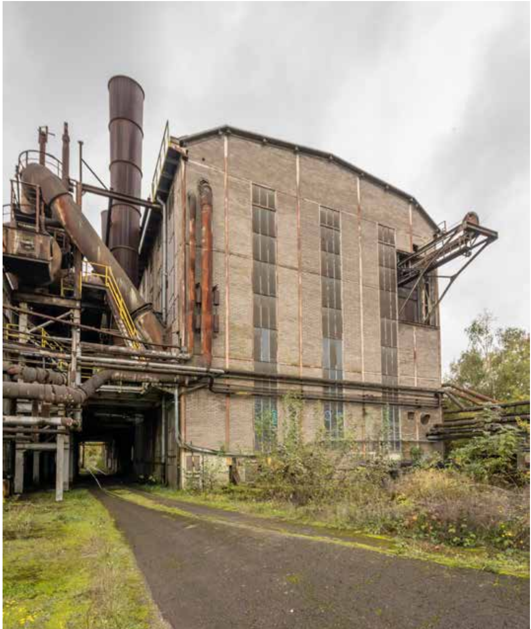
La centrale thermique est le successeur technologique de la Groussgasmaschinn. L'immeuble représente de manière exemplaire l'architecture industrielle des années 1950, ceci tant au niveau des matériaux et techniques utilisés qu'au niveau de son expression architecturale. La façade est constituée d'un pan de fer rempli de briques de laitier.
