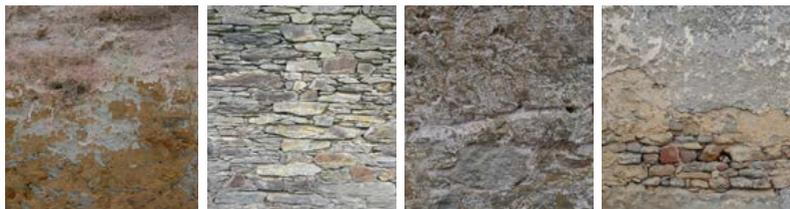
Les dégâts les plus courants sont dus à la dégradation de l'enduit et/ou du mortier qui sont exposés aux intempéries. La pierre ou la brique sont massives et solides et ne doivent que rarement être remplacées.
