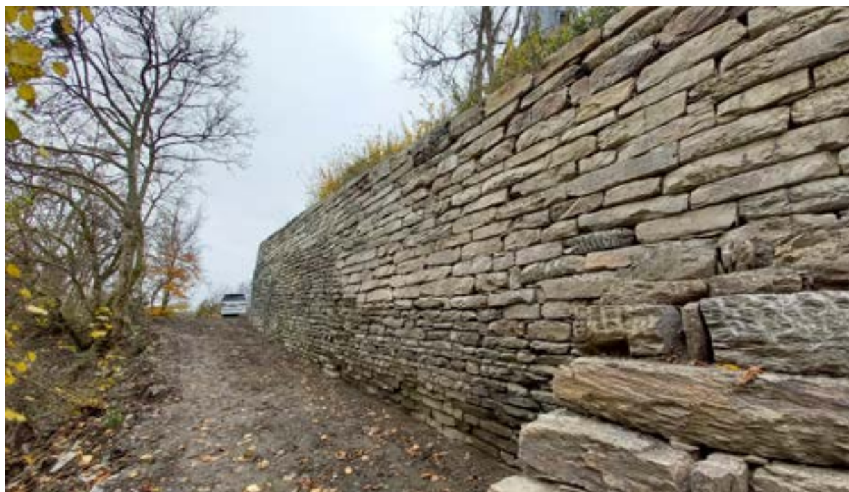
Mur de soutènement du cimetière à Pintsch
