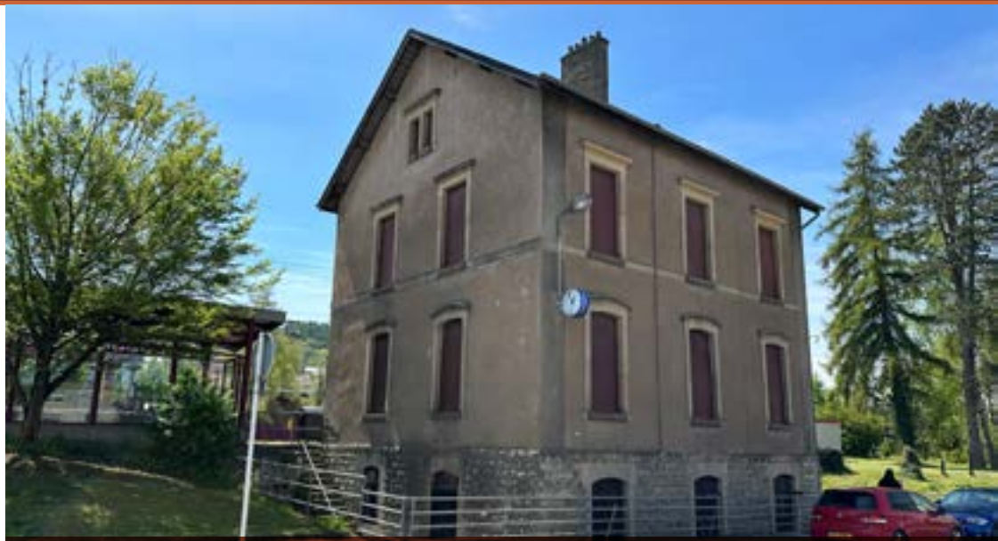
Ancien poste de commande gare de Pétange
