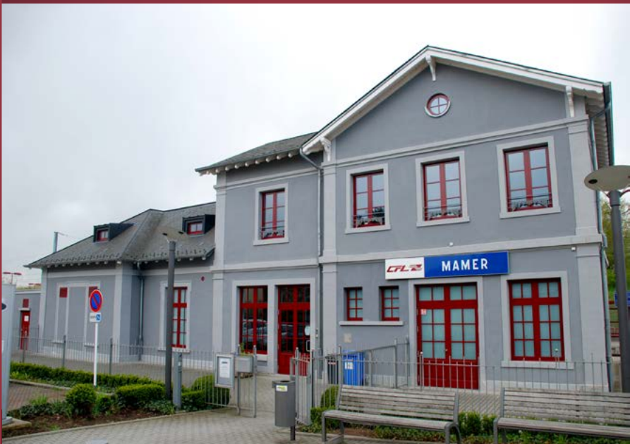
Bâtiment voyageur de la Gare de Mamer , classé
