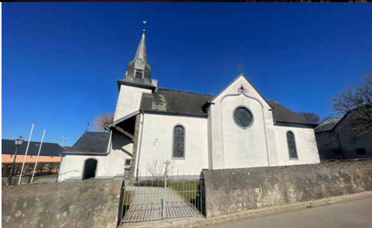
L'église Saint Jean Baptiste avec cimetière et mur d'enceinte à Hupperdange, classé
