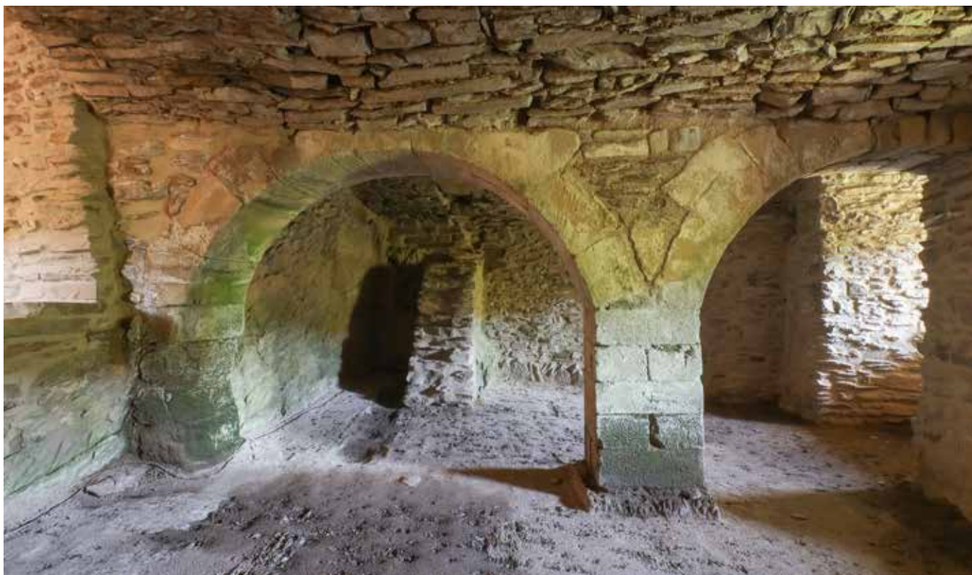
L'espace voûté en-dessous d'un bâtiment disparu a été stabilisé à l'aide de la technique de projection de mortier à la chaux et par la mise en place d'une étanchéité.
