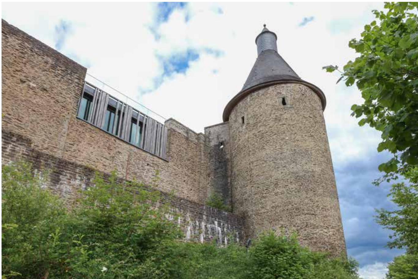
Un bardage en bois a été ajouté devant l'ouverture extérieure donnant sur l'accueil. Il masque la grande baie vitrée et s'intègre dans le nouveau langage architectural choisi pour le site.
