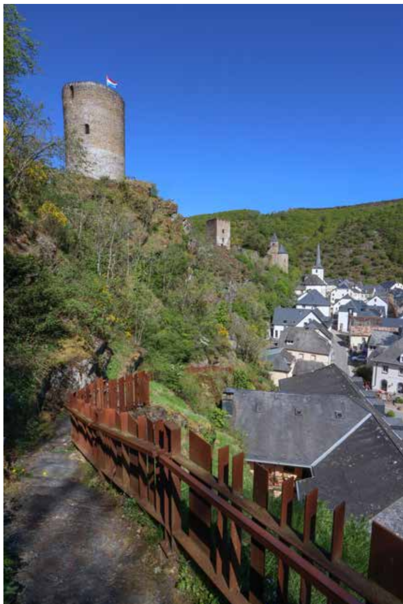
Le village et la tour de guet sont reliés par un chemin historique à forte pente. La montée par escaliers taillés dans la roche a été remise en état et sécurisée par un garde-corps en acier Corten développé pour l'ensemble du site médiéval.
