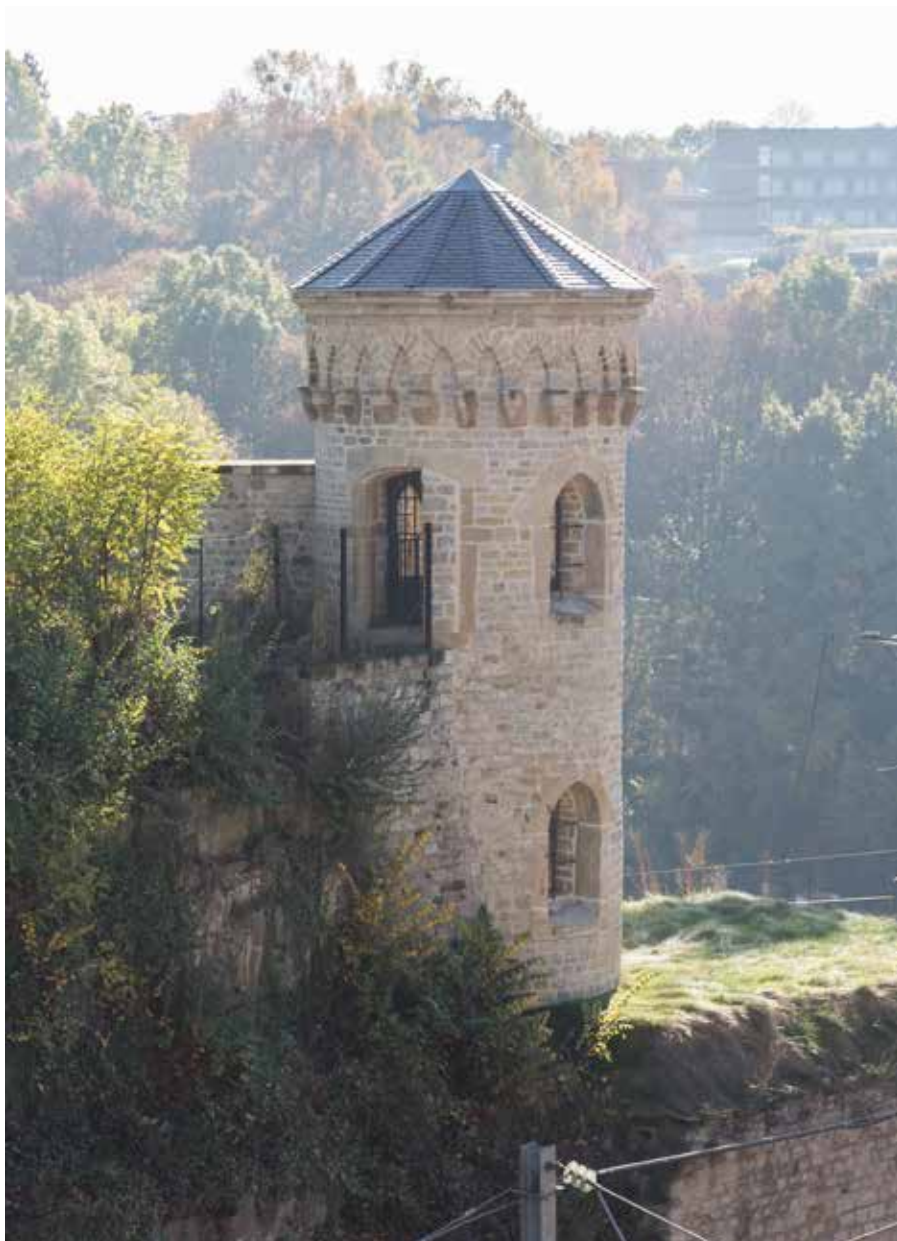
La tourelle couronnant les ouvrages de la batterie prussienne, se situant à l'endroit de la bifurcation des lignes de chemin de fer, est logée sur une plateforme engazonnée cachant la batterie inférieure.
