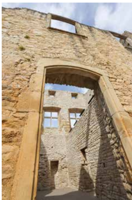
Des témoins de la façade disparue du palais apparaissent par des raccords en maçonnerie qui donnent sur le mur extérieur. Ces vestiges, tout comme la façade orientée vers la cour intérieure du corps de logis, a fait l'objet d'une stabilisation par projection de mortier à la chaux et par l'installation d'ancrages.
