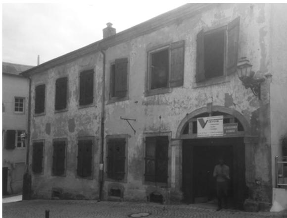
Le projet visait à préserver un maximum d'éléments originaux, notamment la façade historique avec sa corniche et les murs porteurs intérieurs. Un escalier d'origine qui permettait d'accéder à la cave, condamné jadis et remblayé, a été réactivé.
